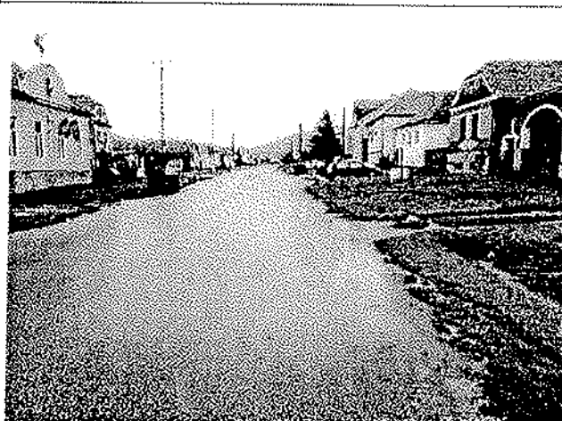
Vedere acces stradal partea din stanga
